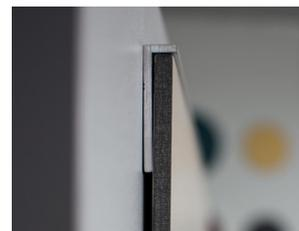
Der zellstoffverstärkte Faserzement garantiert die Nichtbrennbarkeit der Wandverkleidung und verhindert zudem Rauchentwicklung und brennendes Abtropfen.
